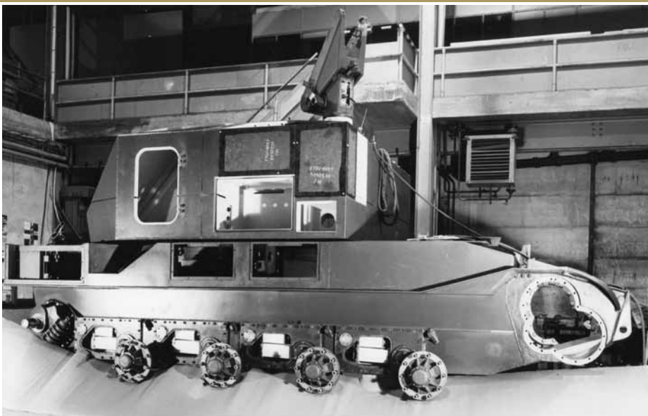
Chassit med torn under montering
